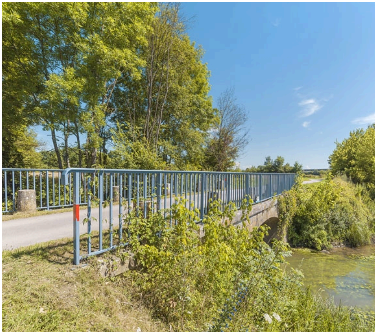
Vue d'ensemble du pont biais. A droite, la Saône.
