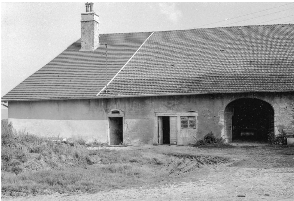
Gouttereau sur rue.
