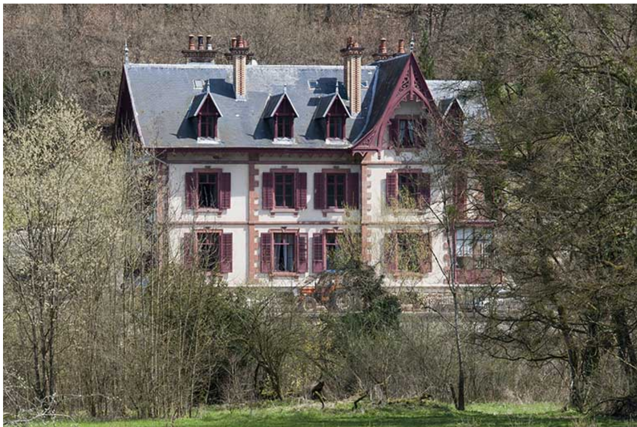
Façade antérieure du logement patronal Sircoulon.
