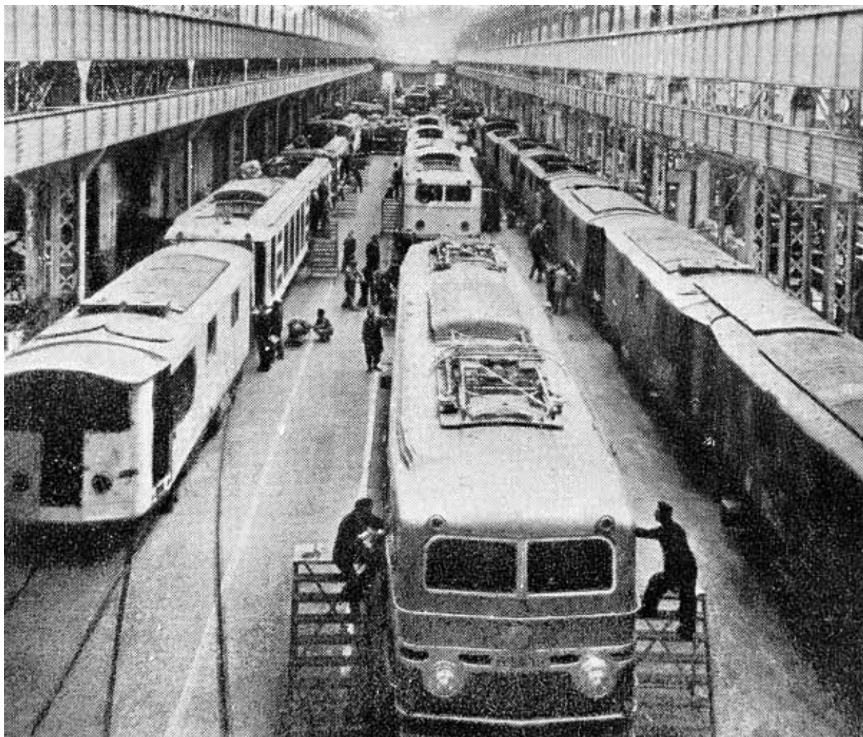
Hall de montage des locomotives électriques.
