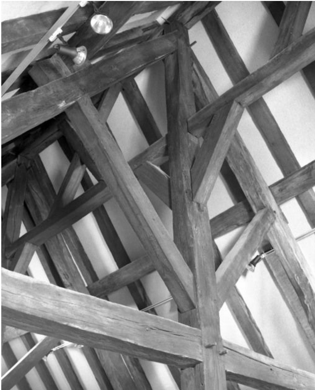
Charpente du niveau supérieur du comble.
