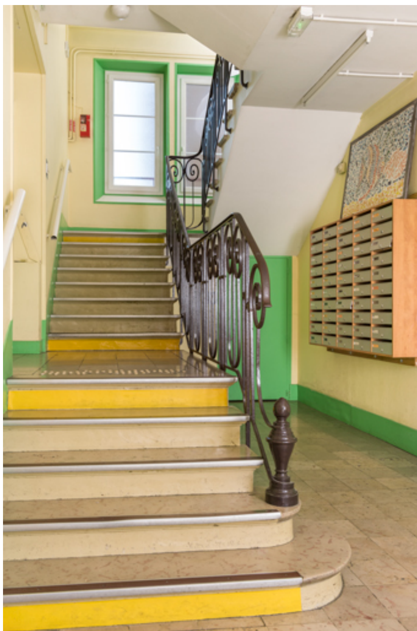
Vue d'un escalier intérieur.
