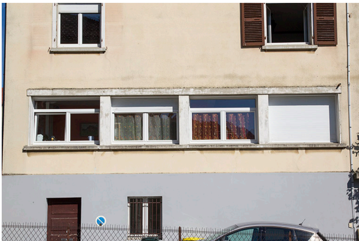
Façade latérale gauche : fenêtres d'atelier.
