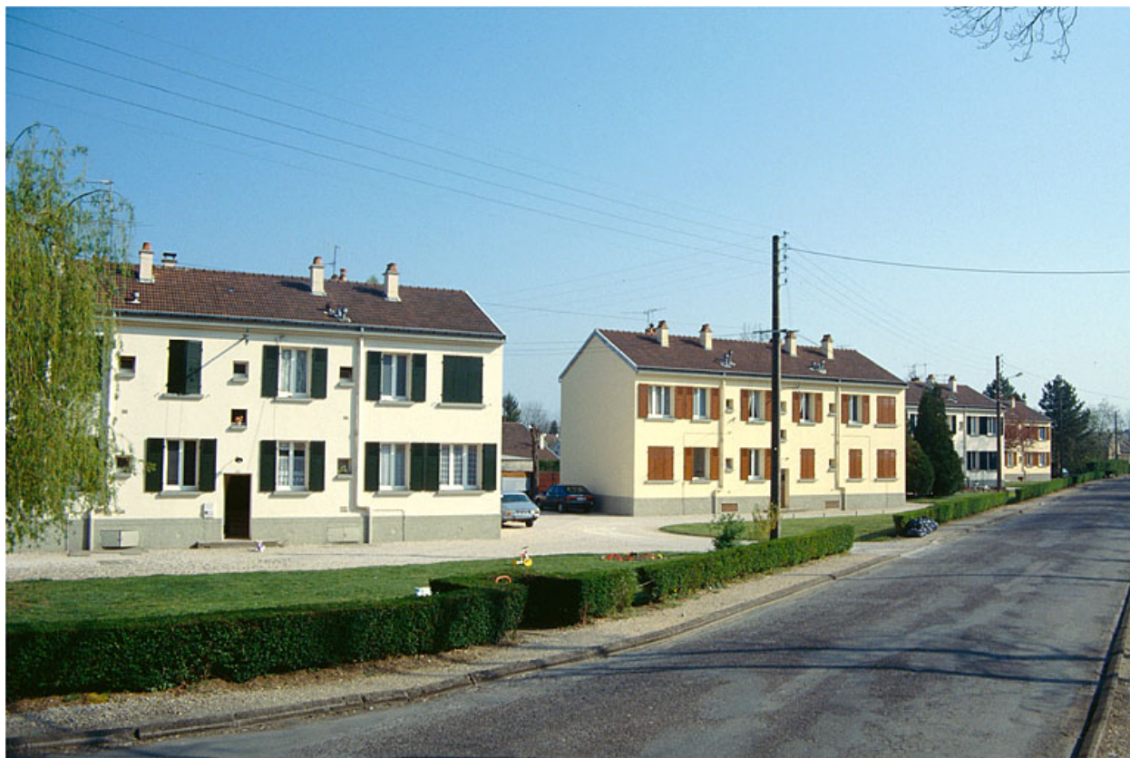
Immeubles semblables, rue des Verneaux.
