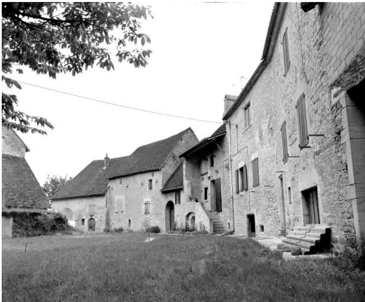
Vue générale depuis l'est.
