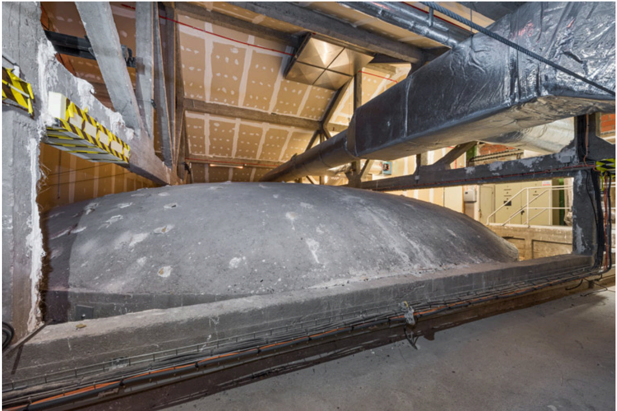
Extrados de la coupole et charpente en béton armé.
