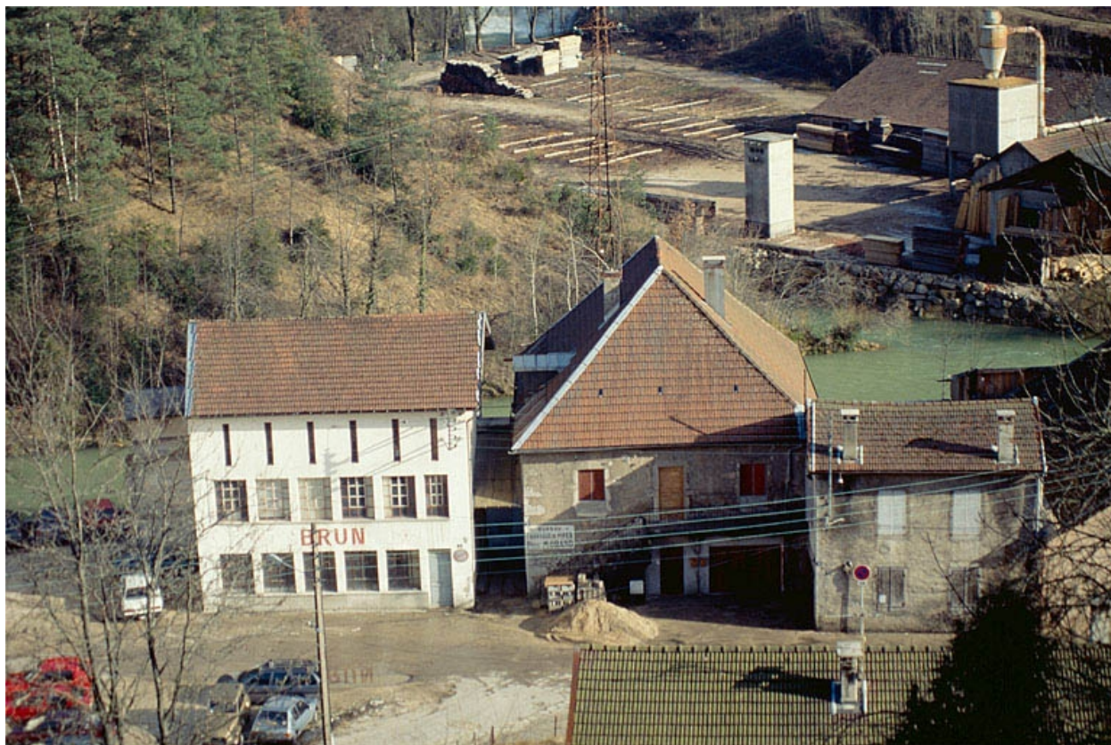
Façade antérieure des bâtiments.
