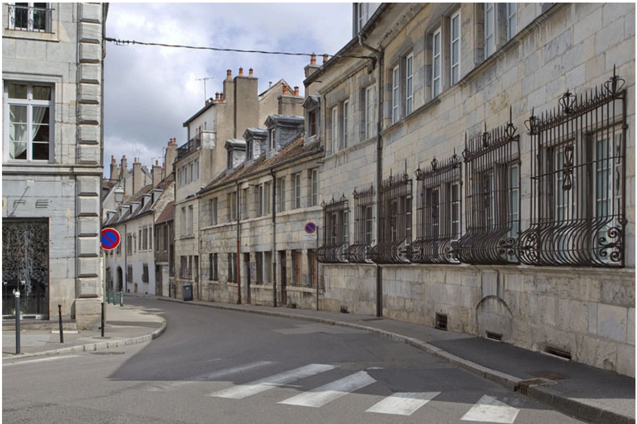
Vue d'ensemble du logis principal dans l'alignement de la rue.
