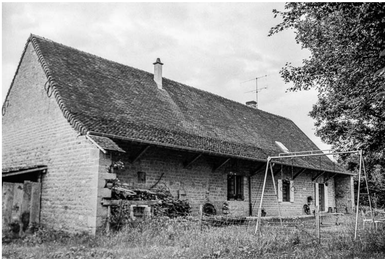
Ferme : façade postérieure.
