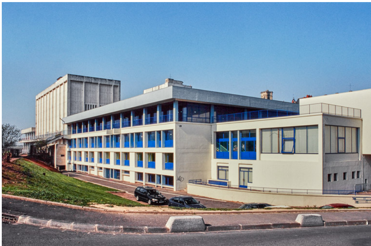
Façade postérieure, de trois quarts droite, en 2000.
