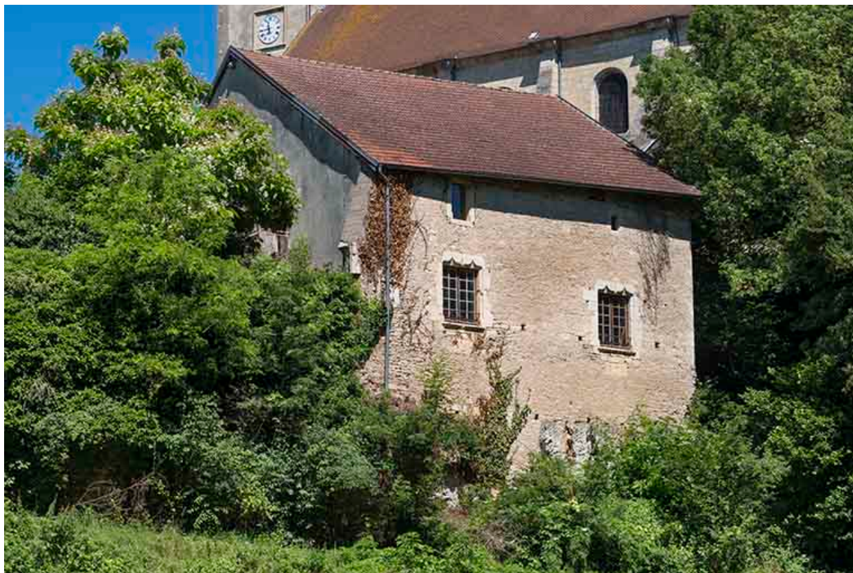
Façade postérieure de l'ancienne cure.
