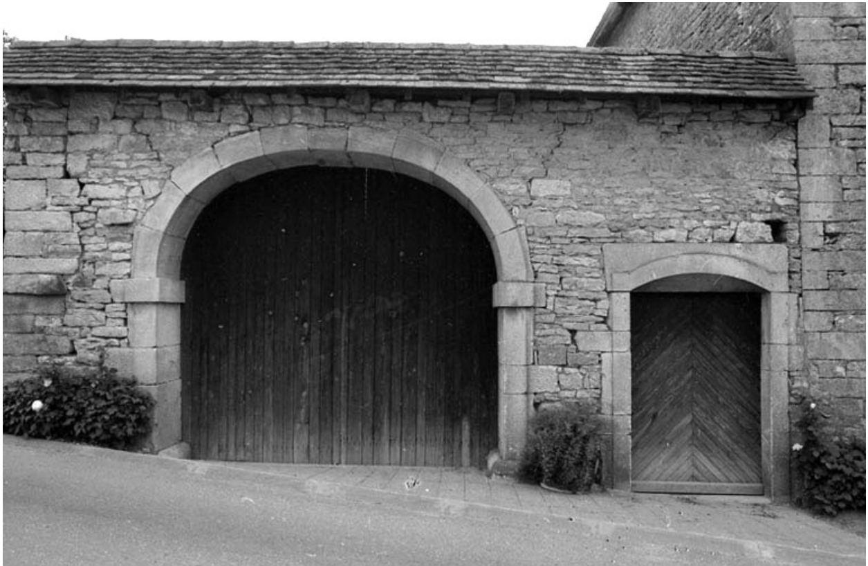
Détail : l'entrée de la cour.
