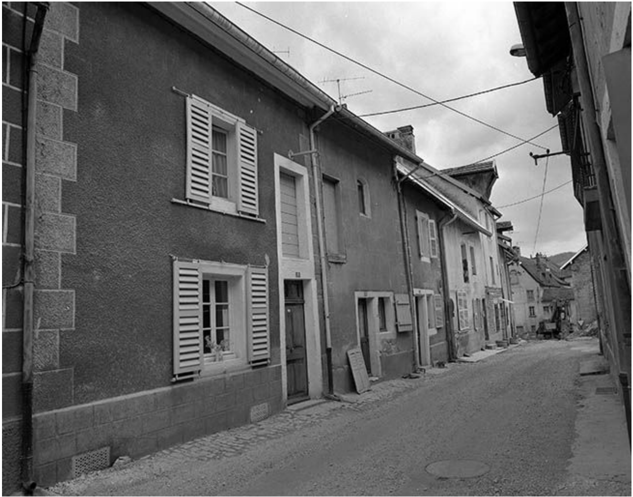
Maisons 14 à 15 rue des Martinets : vue générale.
