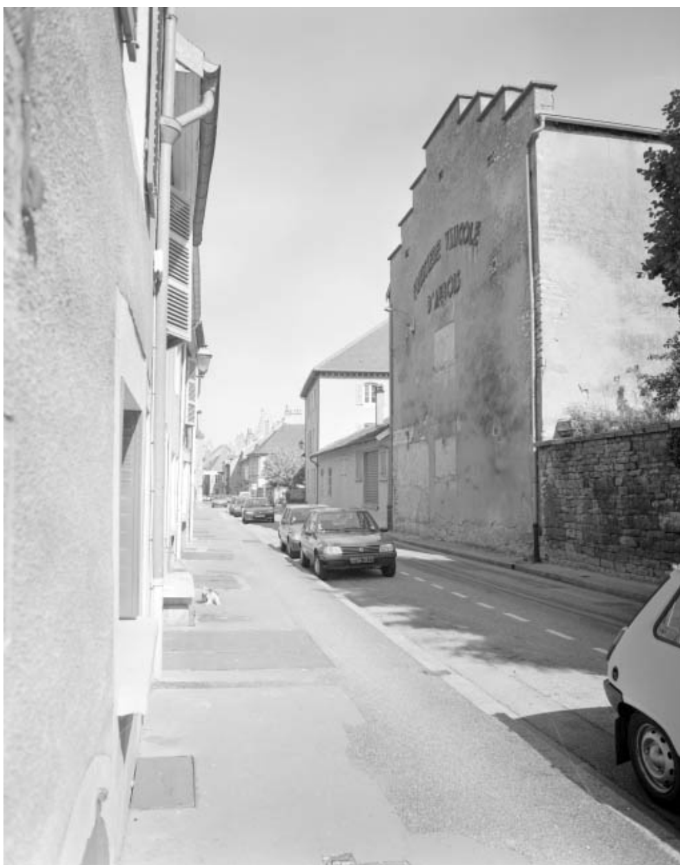
Pignon à redents d'un chai.
