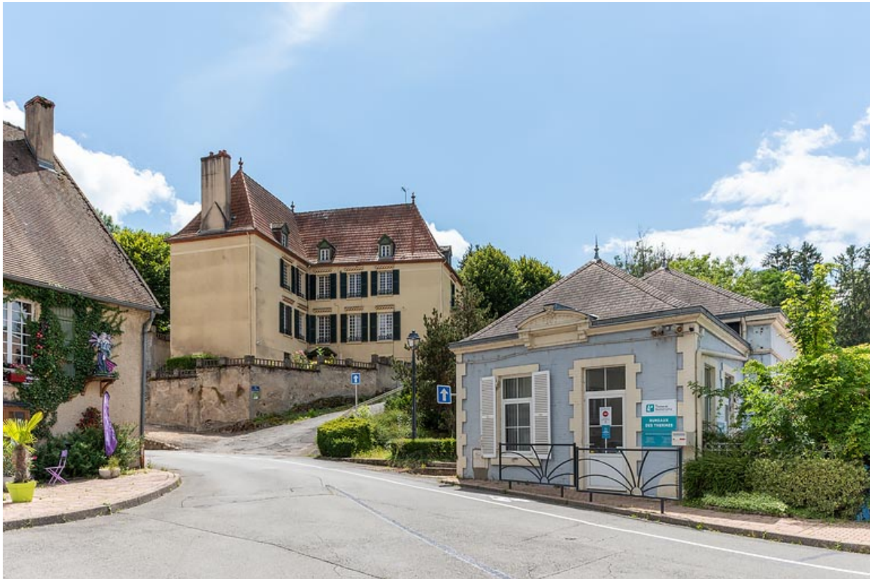
Vue depuis la place d'Aligre, avec un pavillon de l'établissement thermal à droite.
