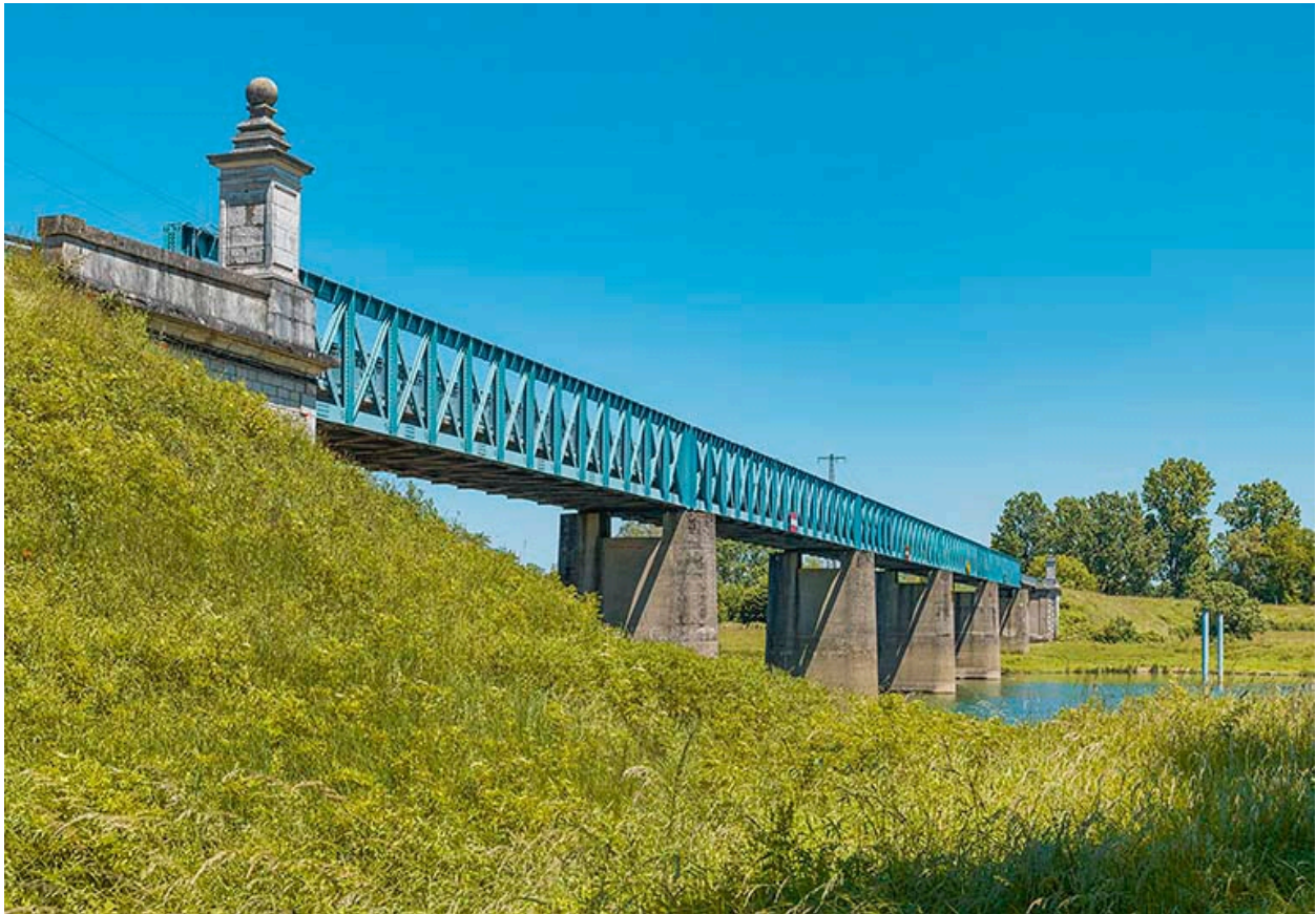
Vue d'ensemble du pont.
