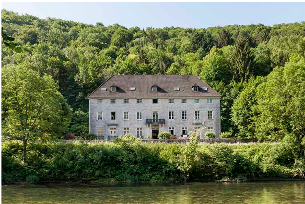
Façade antérieure du logement patronal.
