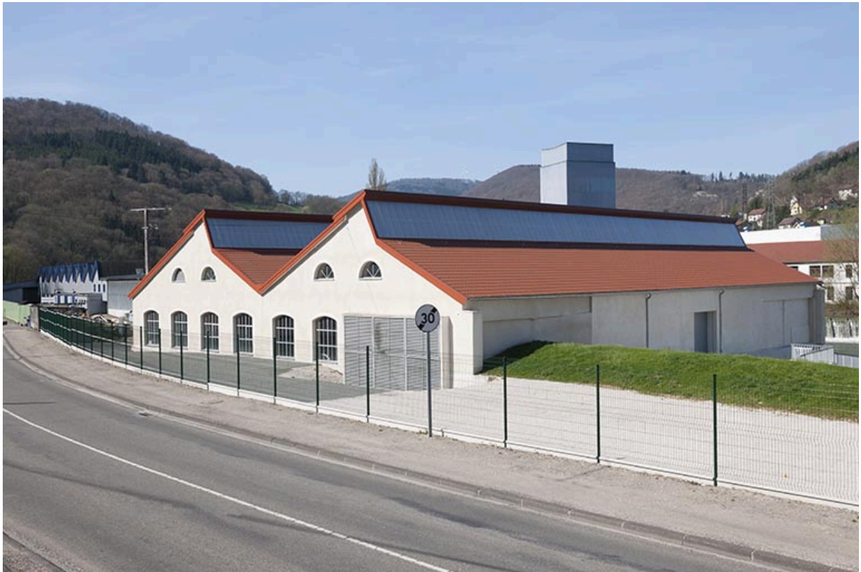
Centrale hydroélectrique (rive droite).
