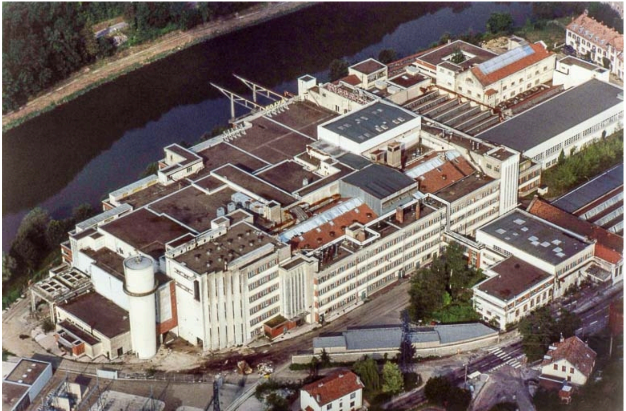
Vue aérienne de l'usine A depuis l'est.
