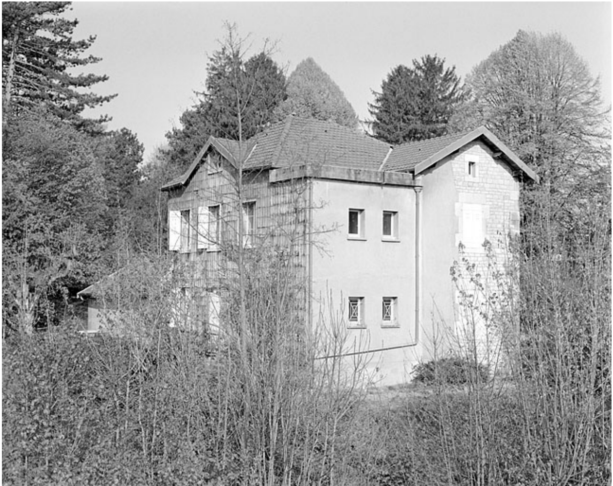
Partie sud : conciergerie, vue du sud-est.
