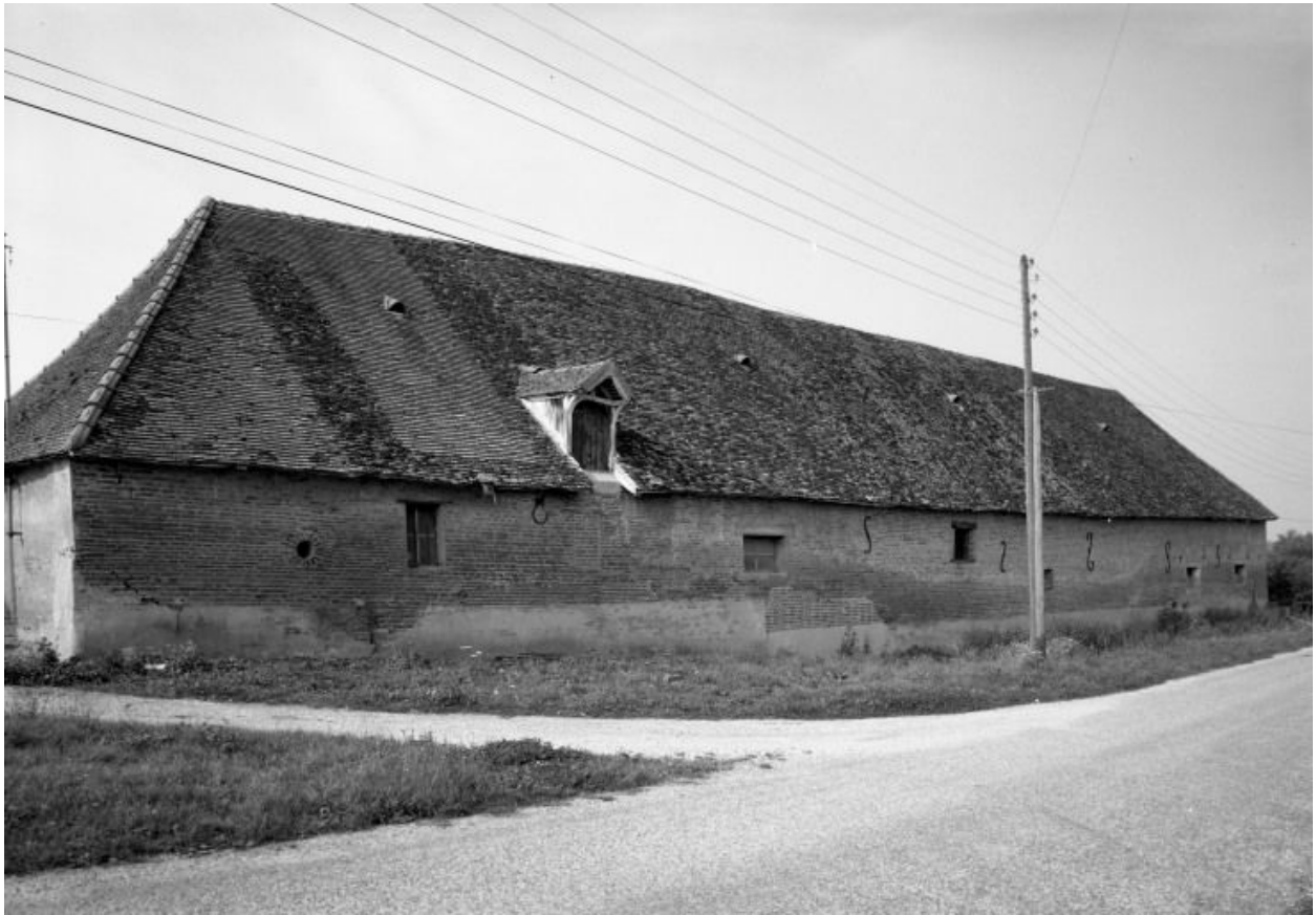
Elévation postérieure des dépendances.
