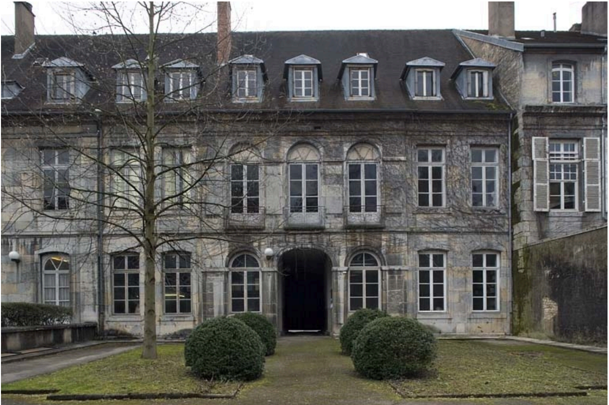
Vue d'ensemble de la façade sur cour, de face.
