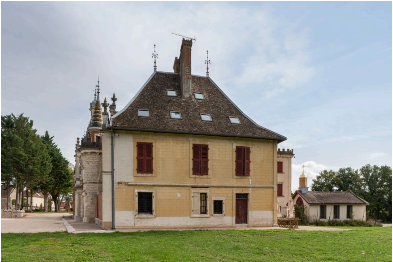
Elévation postérieure (ouest).
