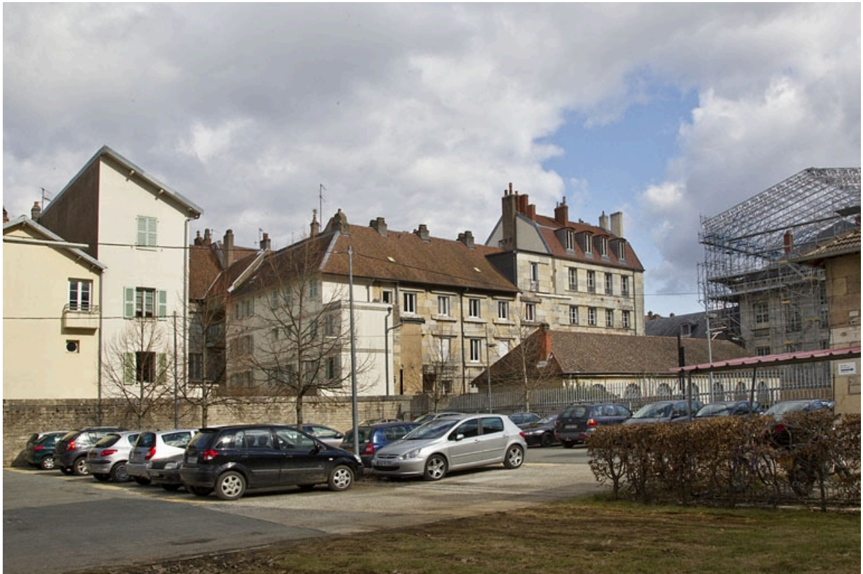
Vue d'ensemble éloignée de l'arrière de l'édifice.
