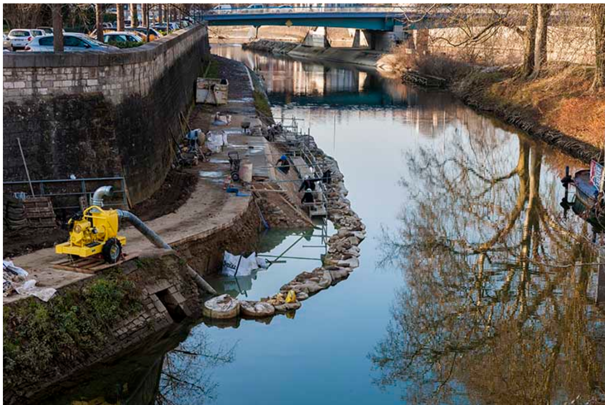
Réfection du perré du chemin de halage en aval du moulin Saint-Paul : vue d'ensemble depuis l'amont.
