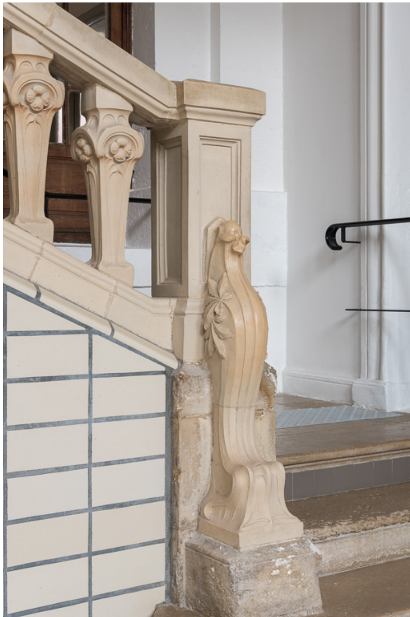
Hall des sources, rampe du degré, détail.
