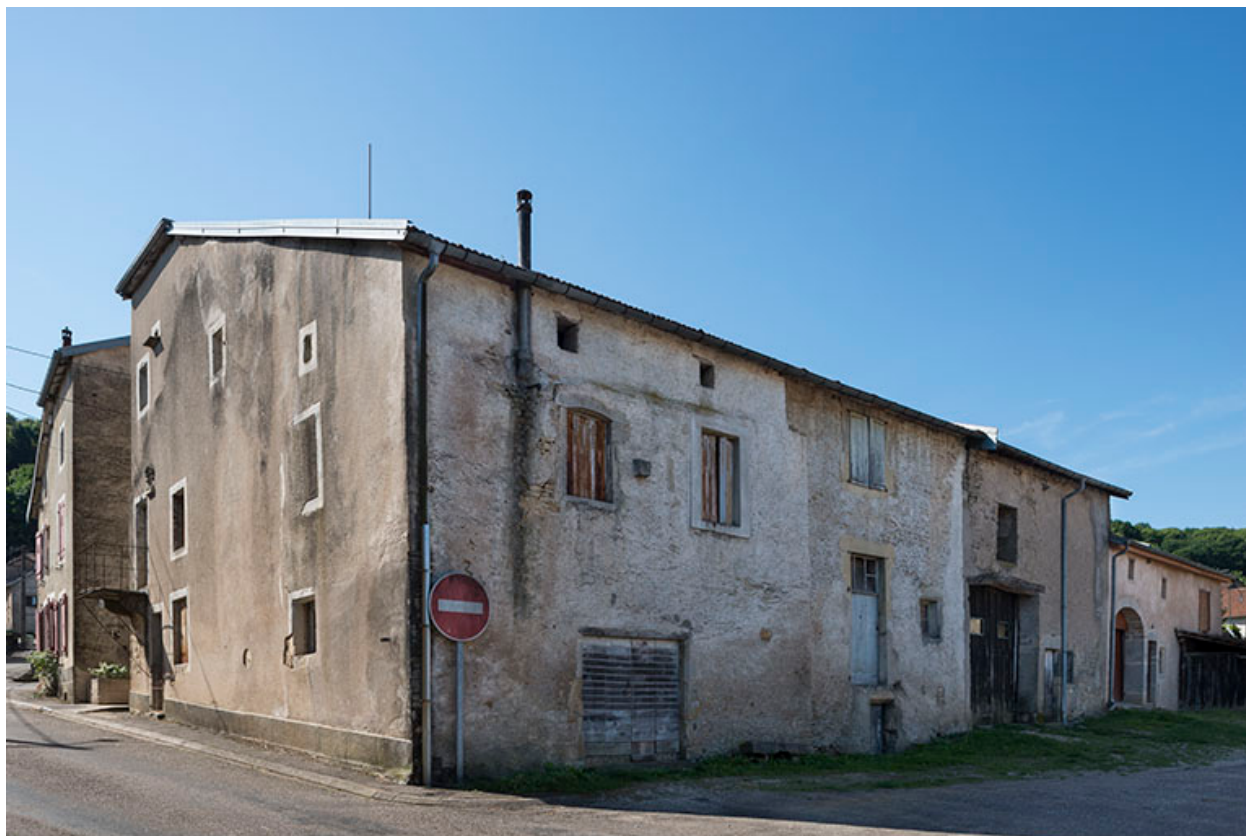
Vue depuis le nord.
