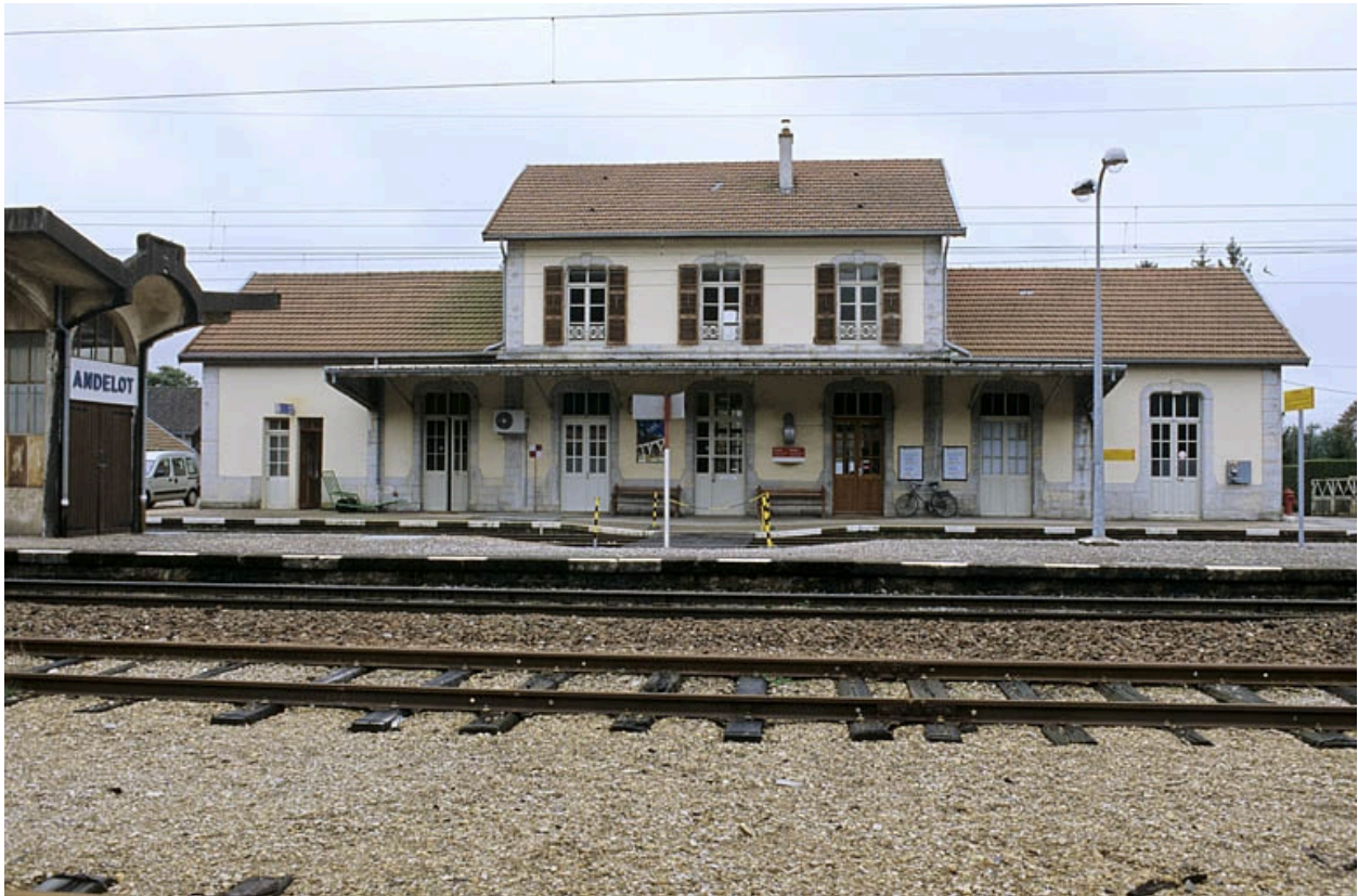
Bâtiment des voyageurs : façade postérieure, de face.
