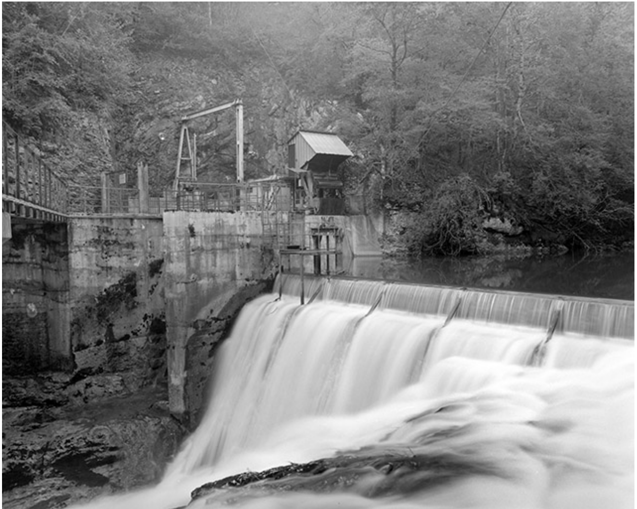
Prise d'eau et barrage.
