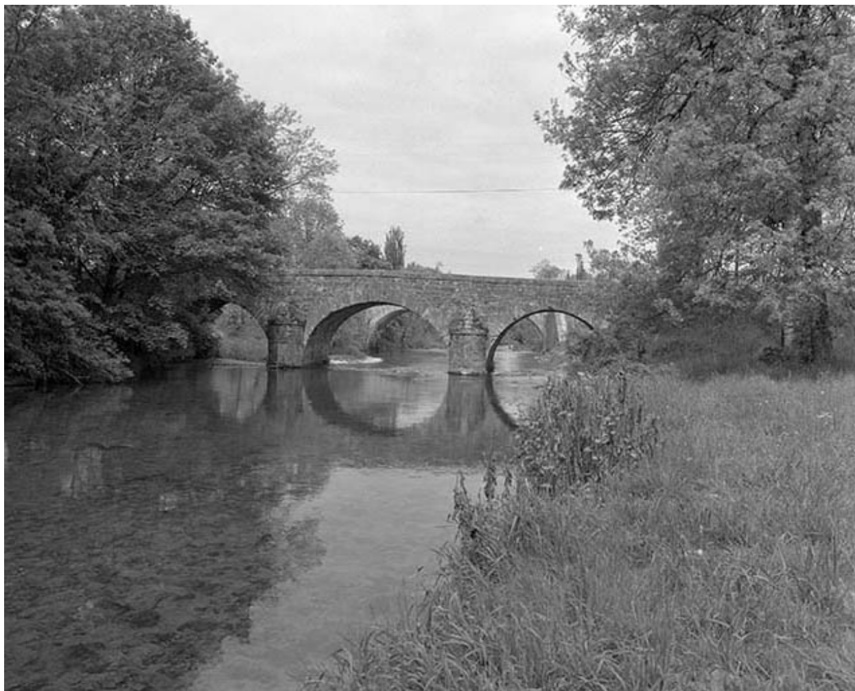
Pont de la route départementale 47.
