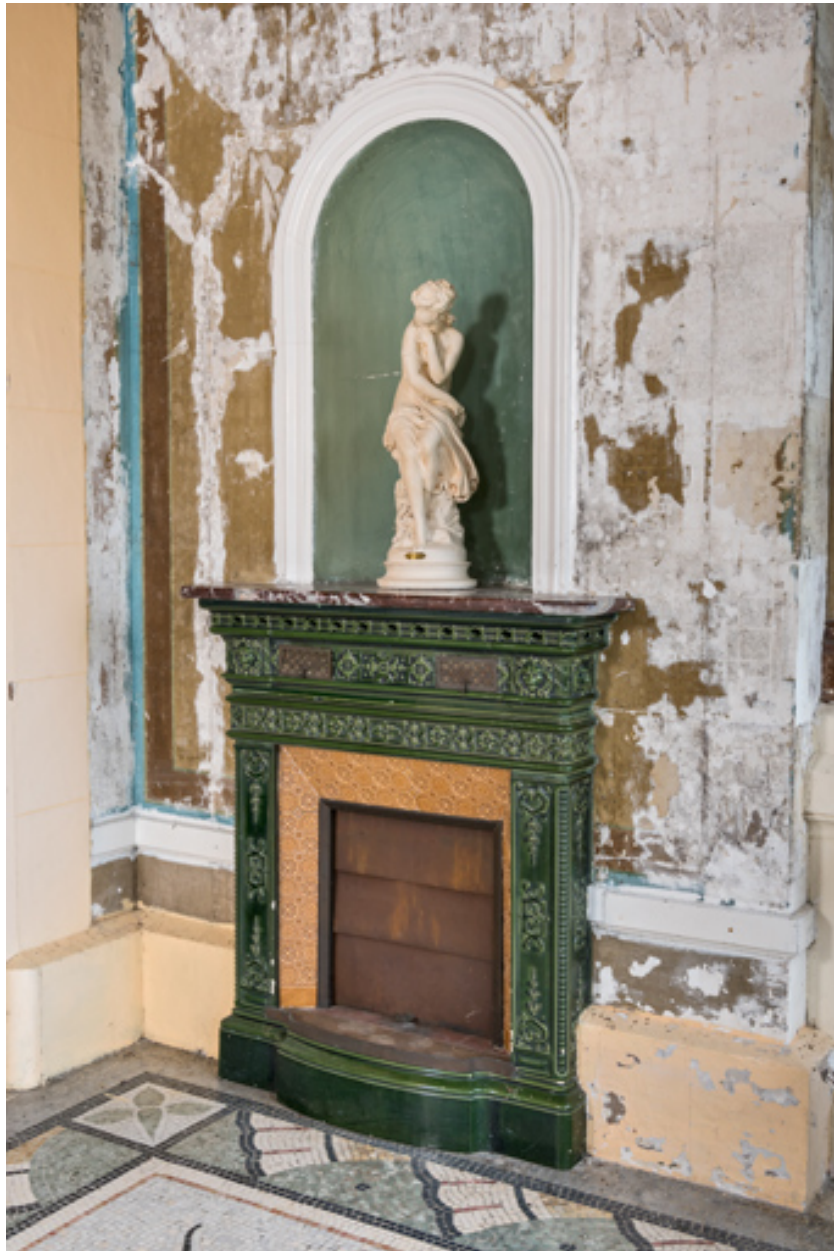
Véranda, manteau de cheminée en céramique surmonté d'une niche.
