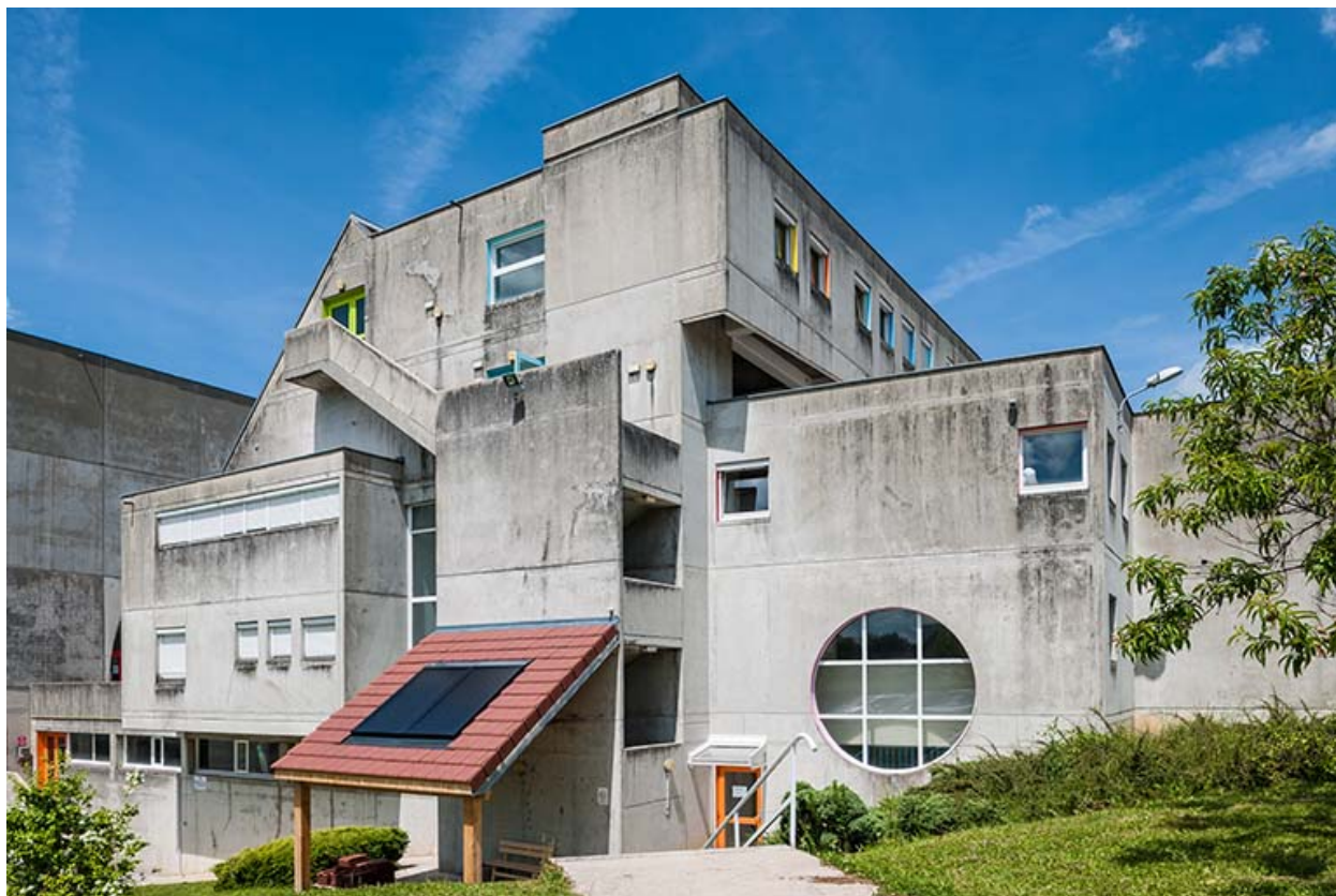
Pignon du bâtiment
