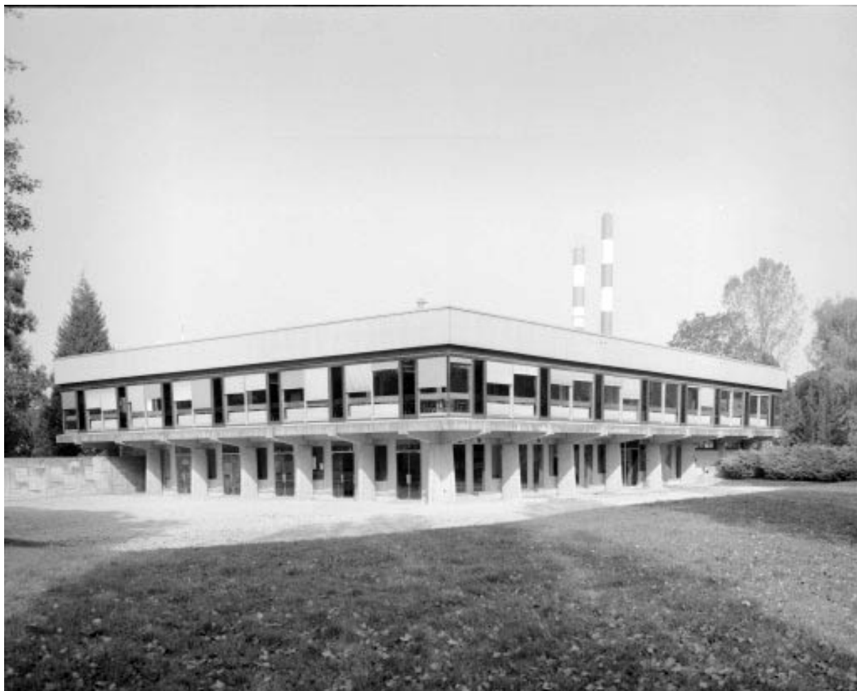
Restaurant d'entreprise vu de trois quarts gauche (vue rapprochée).
