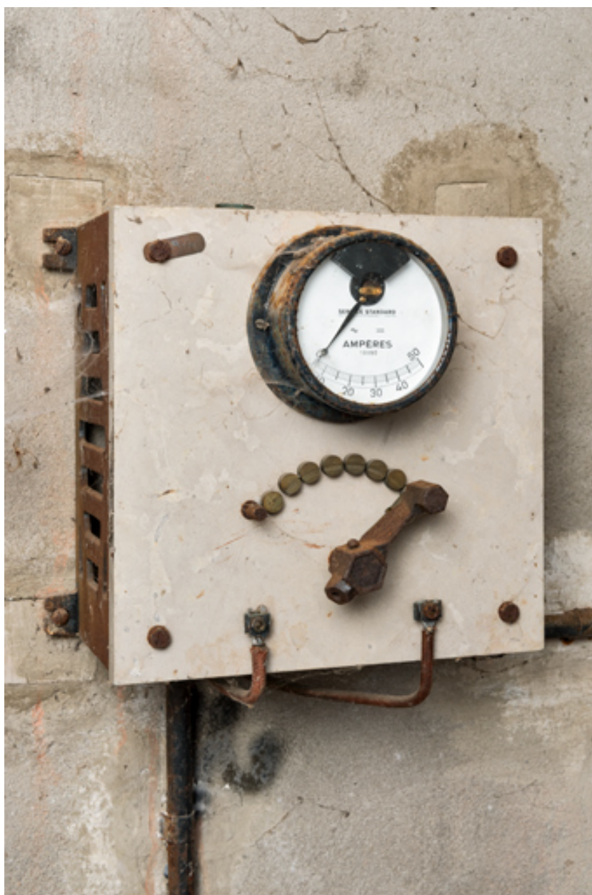
Cabine de projection : un rhéostat.
