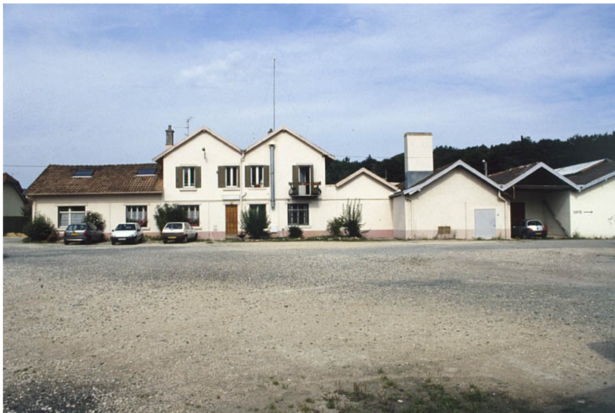
Façade postérieure des bâtiments sur rue.
