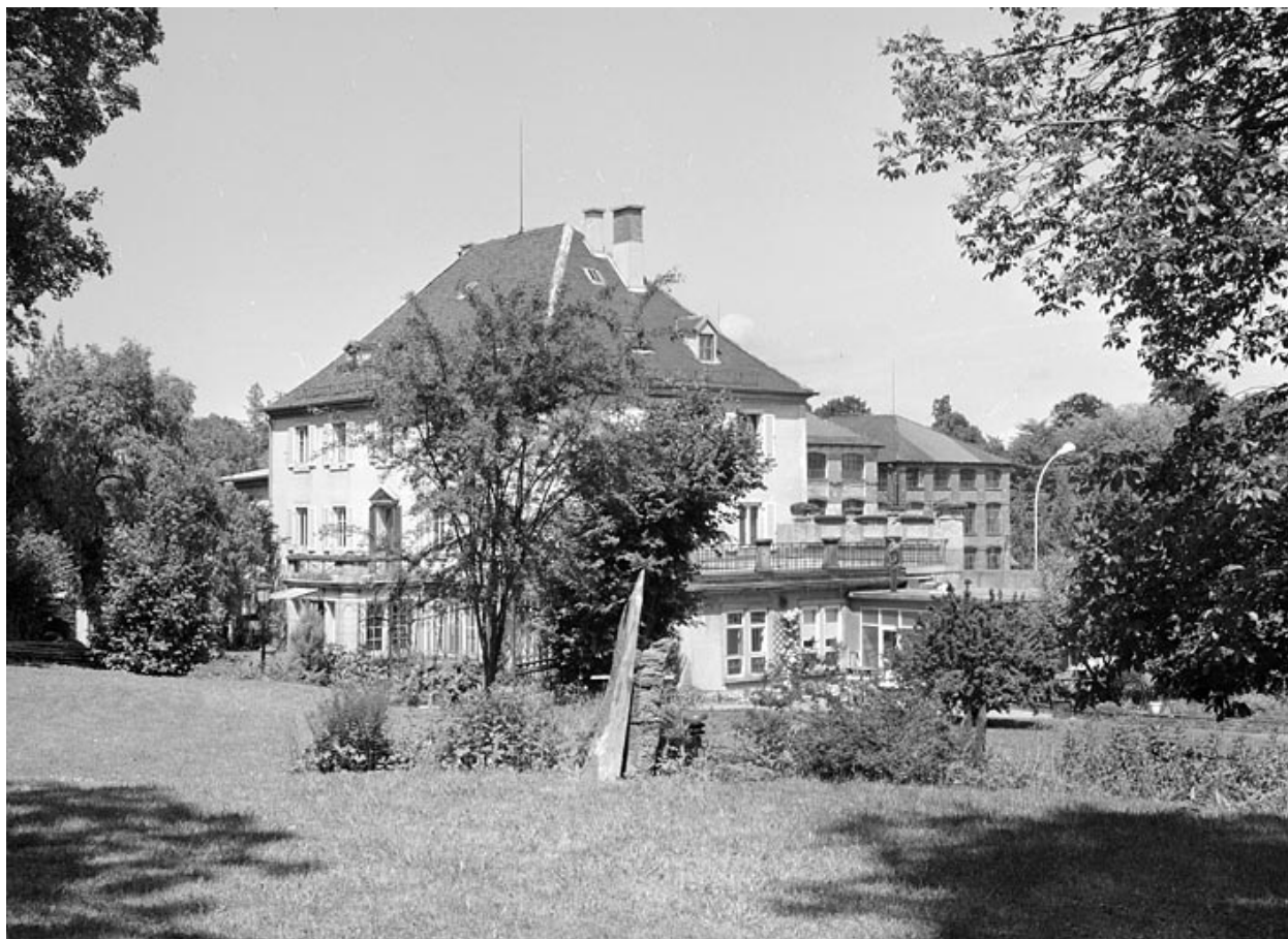
Vue d'ensemble depuis le jardin.
