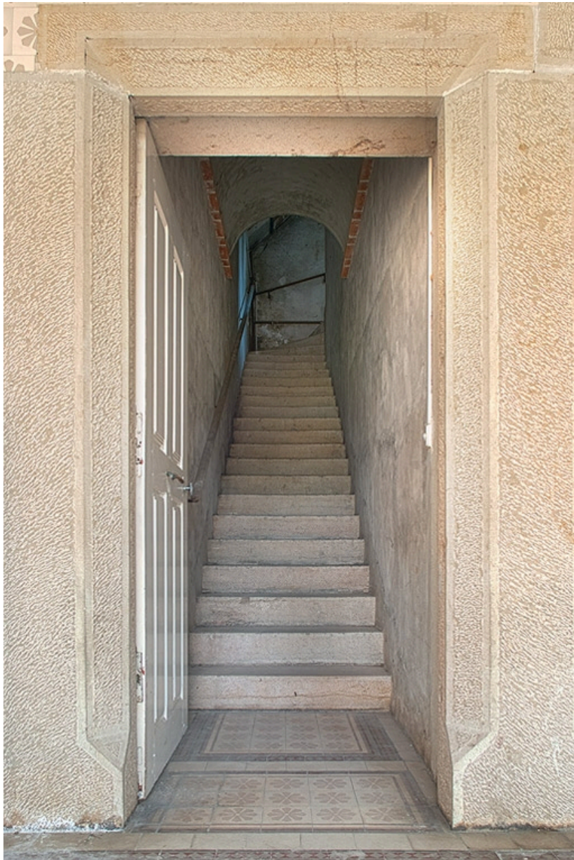
Corps central, escalier du comble.
