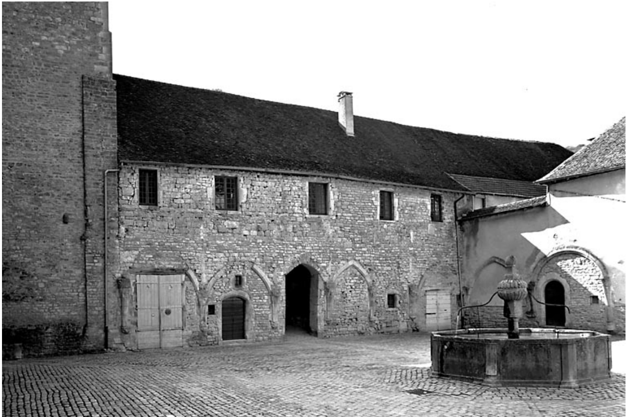
Côté est de la cour du cloître, vue de trois quarts.
