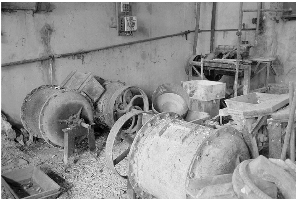
Moteurs électriques des équipes.
