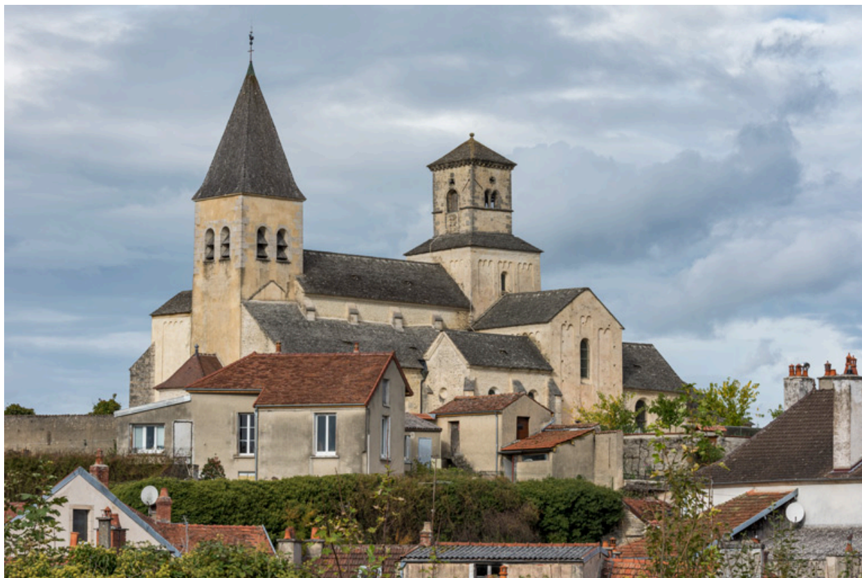
Vue d'ensemble côté nord.
