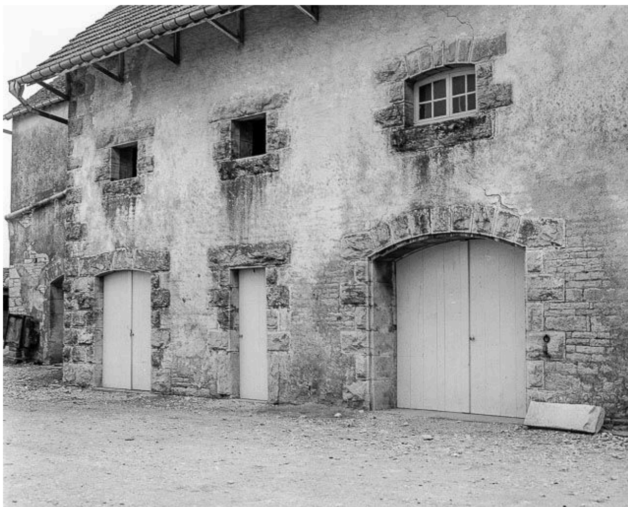
Partie agricole : détail de la façade postérieure.
