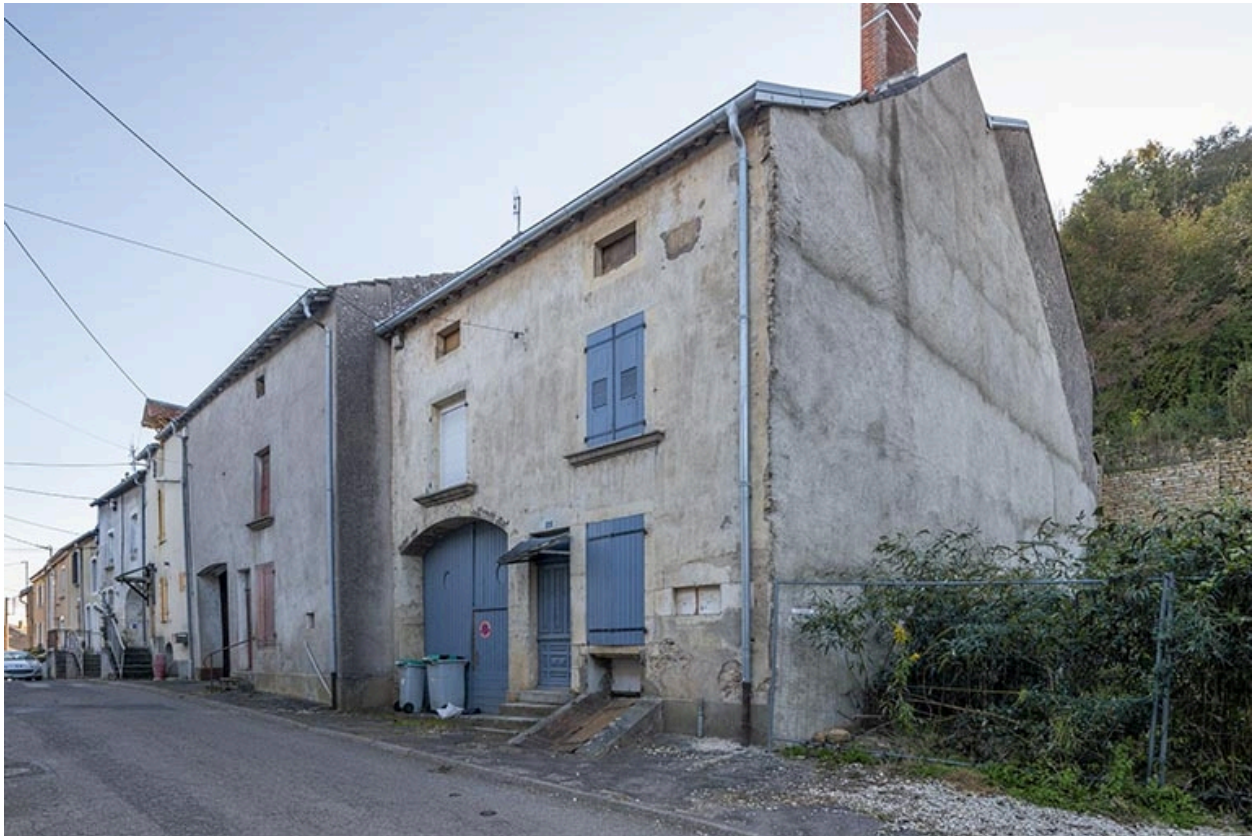
Rue Thiers, alignement du côté pair devant le n° 32, vue vers le nord-est.
