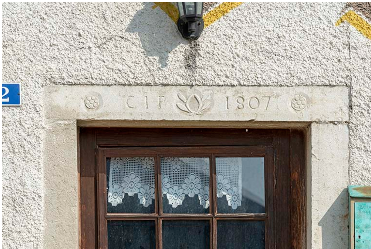
Façade antérieure : linteau daté.
