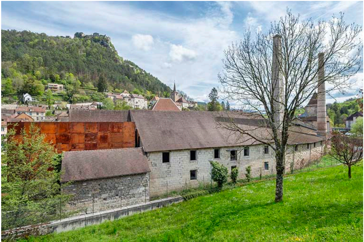
Façades ouest des bâtiments de production.
