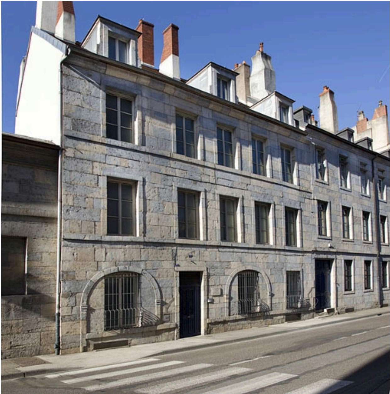
Vue d'ensemble de la façade antérieure, de trois quarts gauche.
