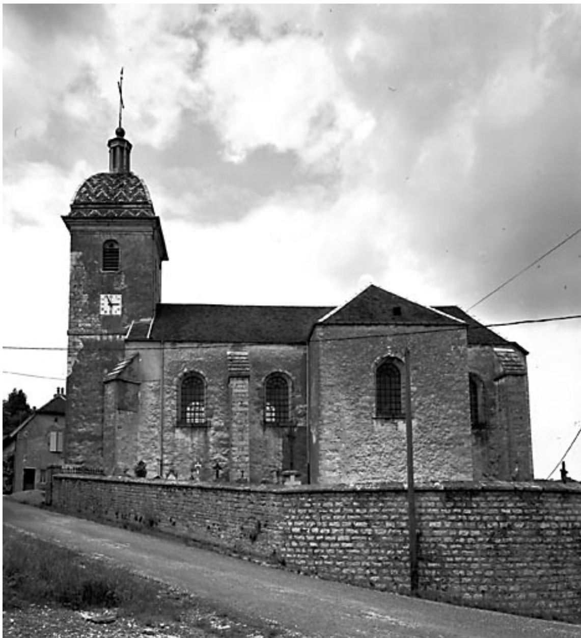
Façade latérale sud.
